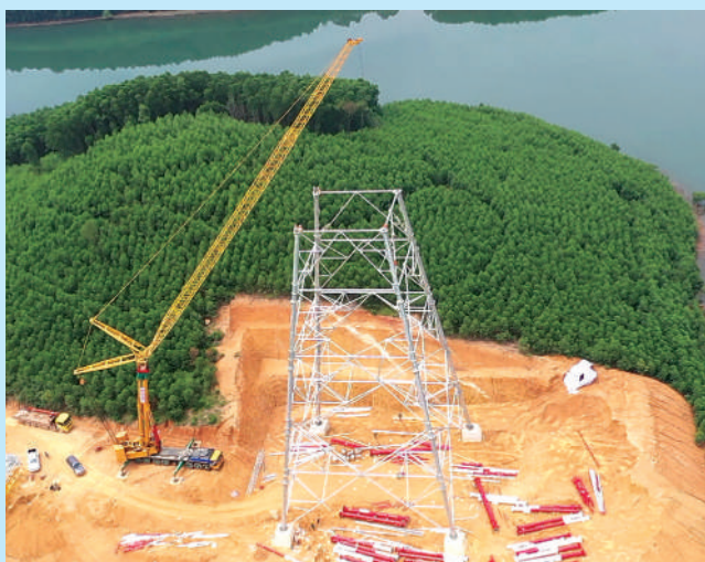
Cùng với chủ đầu tư, các nhà thầu cũng đang ra sức đẩy nhanh tiến độ dựng cột, kéo dây. Trong ảnh: Thi công vị trí cột 175, cao 145m, nặng 126 tấn cung đoạn 500kV Quảng Trạch - Quỳnh Lưu.
