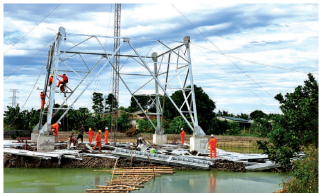
Đội xung kích Điện lực Đồng Nai triển khai thi công tại vị trí VT132 (huyện Nông Cống, Thanh Hóa)
