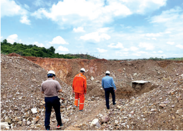
Lãnh đạo EVN và EVNSPC trực tiếp kiểm tra hiện trường chuẩn bị các giải pháp thi công
