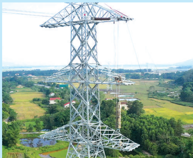
Thi công kéo dây cung đoạn 500kV Quảng Trạch - Quỳnh Lưu trên địa bàn tỉnh Hà Tĩnh.
