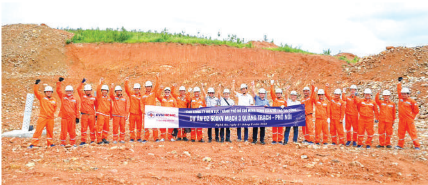
Chiều 1/6, các đội xung kích của các Tổng Công ty Điện lực đã nhận vị trí thi công để nhanh chóng bắt tay vào triển khai công việc
