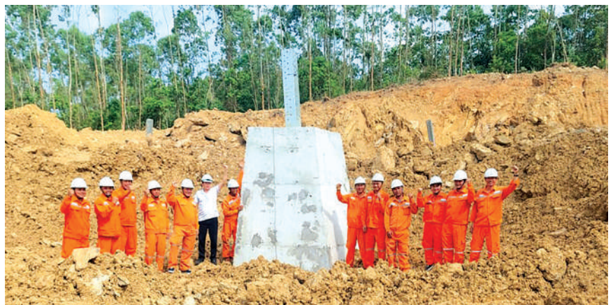
Lực lượng xung kích của EVNCPC đã tiếp cận vị trí 28 Dự án đường dây 500kV mạch 3 cung đoạn Quỳnh Lưu - Thanh Hóa thuộc địa bàn thị xã Hoàng Mai, tỉnh Nghệ An
