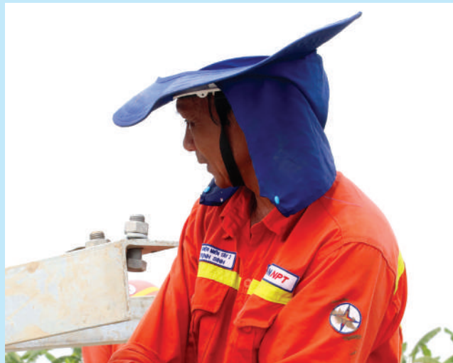
Những giọt mồ hôi rơi, lưng áo ướt đẫm... đã phần nào nói lên sự vất vả của lực lượng thi công trên công trường trong thời tiết nắng nóng, oi bức.
