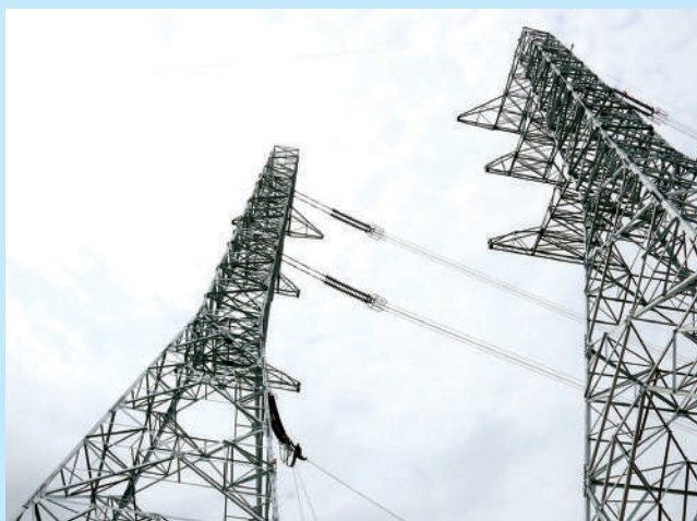
Công nhân “lơ lửng” trên độ cao hàng chục mét thi công kéo dây cung đoạn NMNĐ Nam Định 1 - Phố Nối trên địa bàn tỉnh Thanh Hóa
