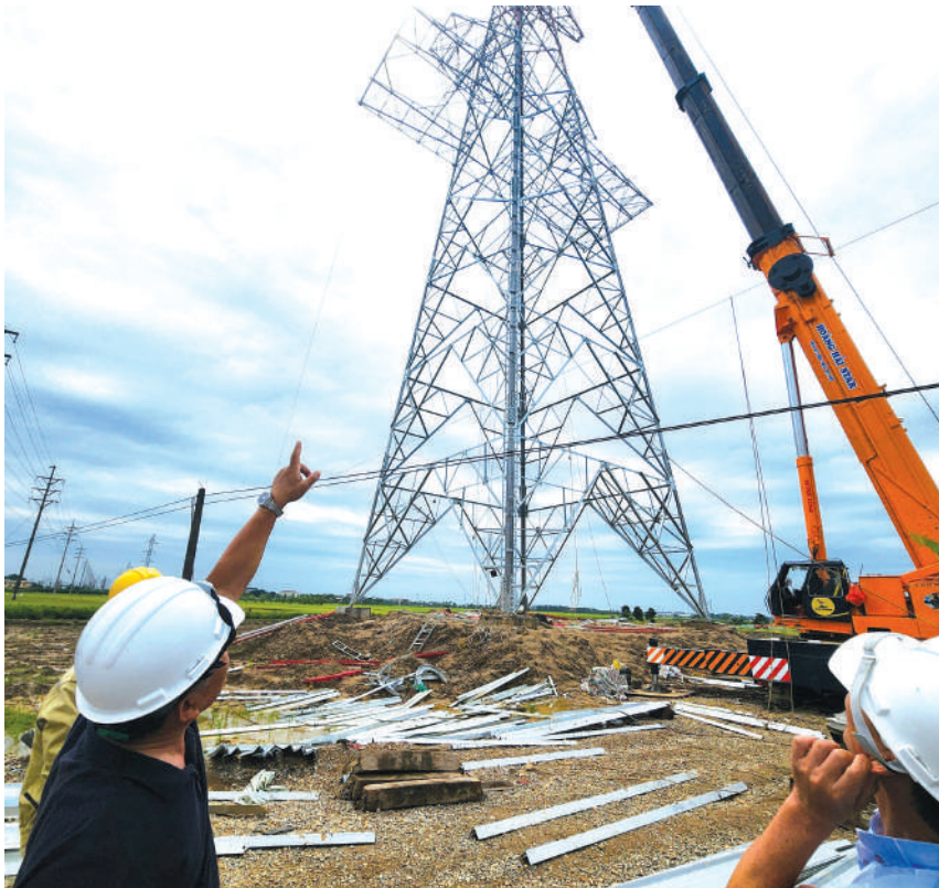
Vị trí 248 do TTĐ Đông Bắc 3 thực hiện sắp hoàn thành
