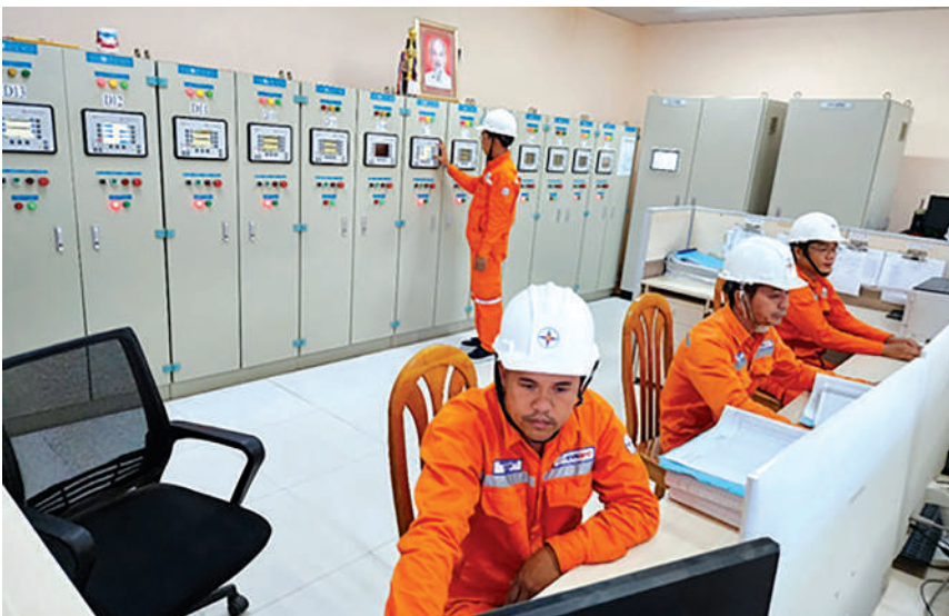
Tổ chức trực xử lý sự cố, sửa chữa điện trong thời gian diễn ra kỳ thi
