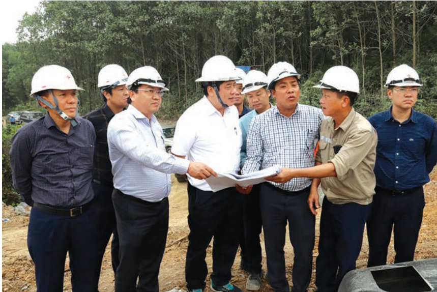
Đoàn công tác kiểm tra tiến độ thi công Dự án Đường dây 500kV Quỳnh Lưu - Thanh Hóa đoạn trên địa bàn tỉnh Thanh Hóa
