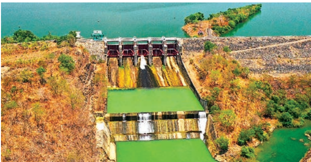
Tại cửa đập hồ thủy điện Srêpốk 3, Nhà máy luôn duy trì dòng chảy môi trường qua đập để đưa nước về hạ du khi tổ máy không vận hành
