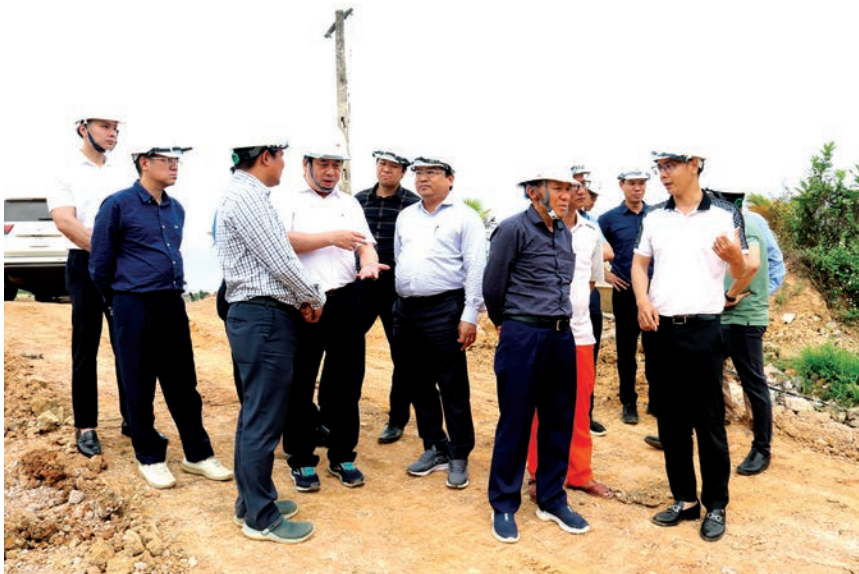
Lãnh đạo EVN yêu cầu cầu nhà thầu thi công các vị trí móng cọc tăng cường nhân lực, thiết bị, tăng tốc tiến độ hơn nữa
