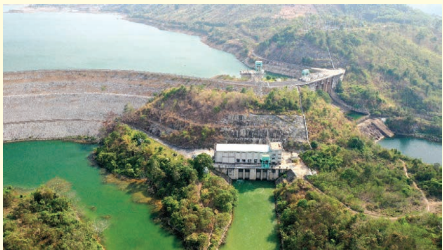
Nhà máy Thủy điện Buôn Tua Srah vận hành đảm bảo hài hòa giữa điều tiết nước hạ du và giữ nước đảm bảo cấp điện cao điểm mùa khô
