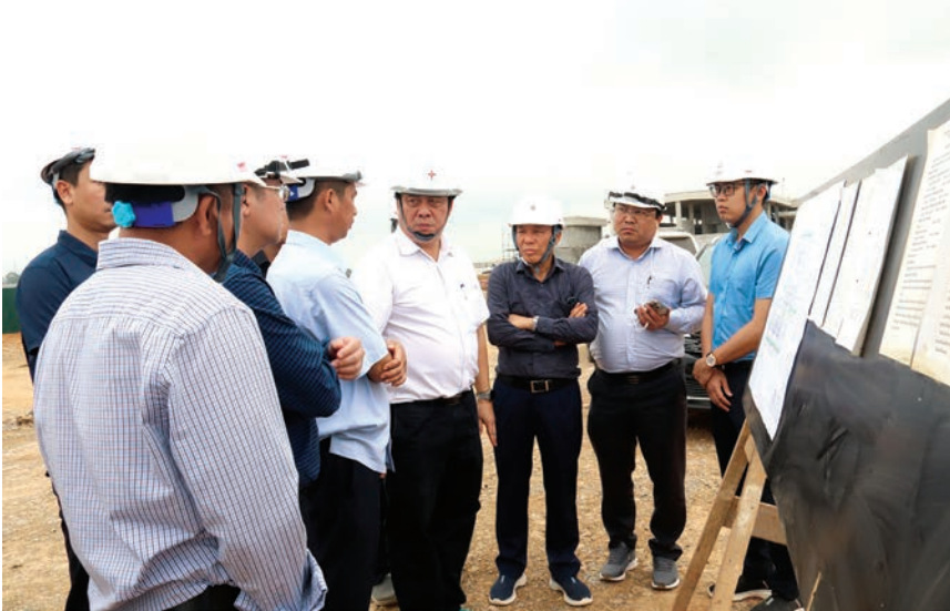
Đoàn công tác nghe nhà thầu báo cáo tiến độ thi công TBA 500kV Thanh Hóa
