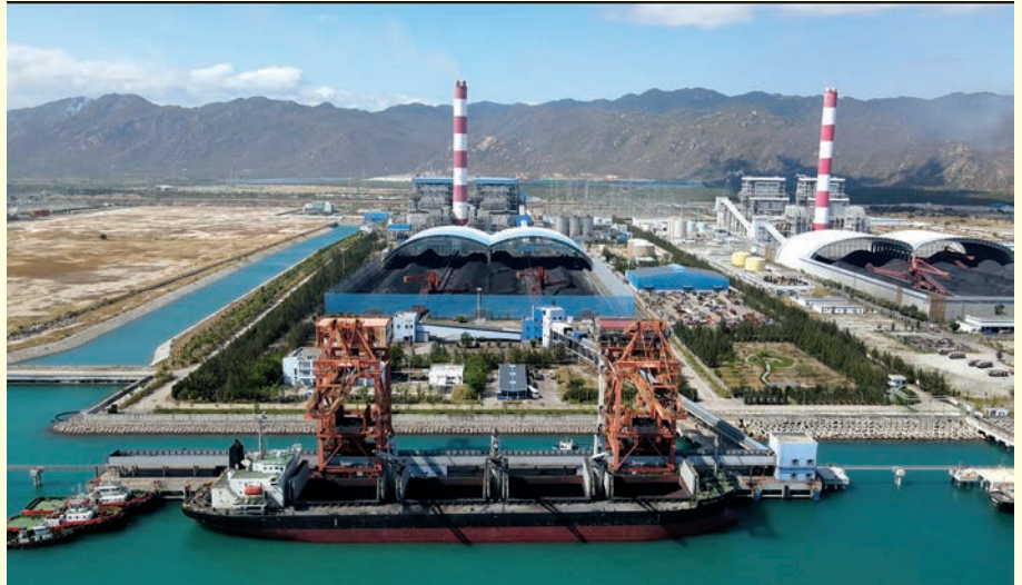
Hiện tại, lượng than tồn kho của Nhà máy Nhiệt điện Vĩnh Tân 2 đã vượt định mức tồn kho cao điểm mùa khô
