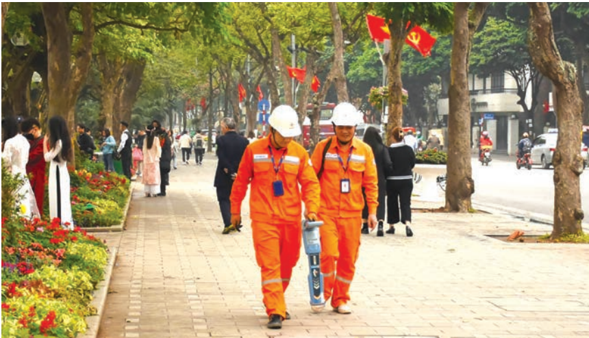
EVNHANOI kiểm tra tình trạng tuyến đường dây ngầm khu vực phố đi bộ tại Hồ Hoàn Kiếm
