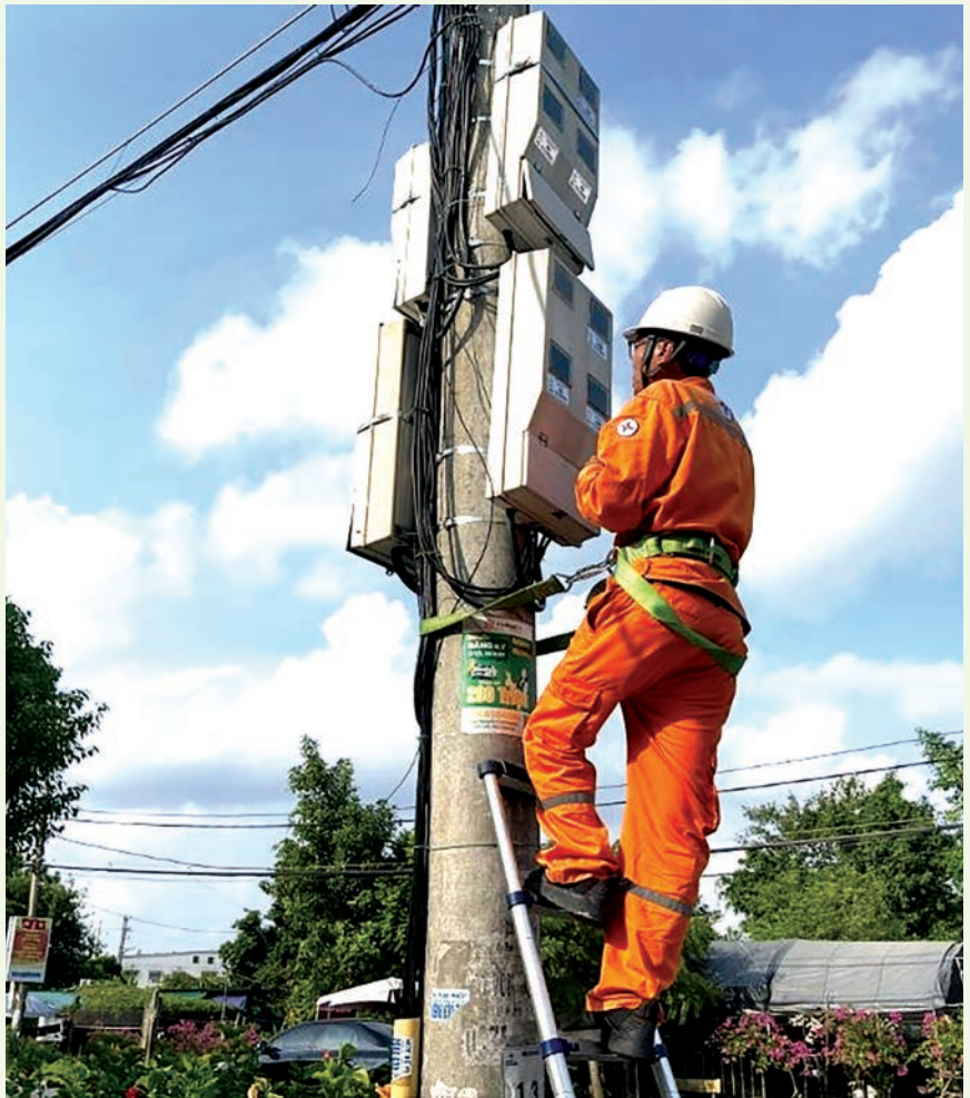
Công nhân Điện lực Gia Lộc kiểm tra kết nối công tơ điện tử đo xa sau lắp đặt
