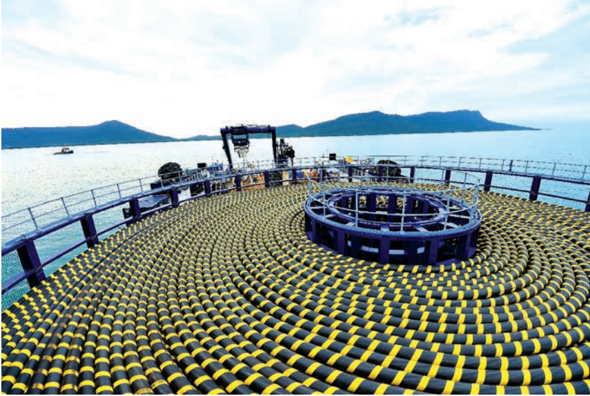
Hình 2: Thi công kéo cáp điện vượt đại dương của công trình đường dây 110kV xuyên biển Hà Tiên-Phú Quốc
