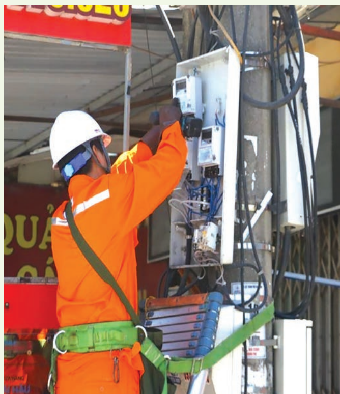
Công nhân Điện lực TP Hải Dương thay thế định kỳ công tơ cơ khí bằng công tơ điện tử đo xa trên địa bàn Thành phố
