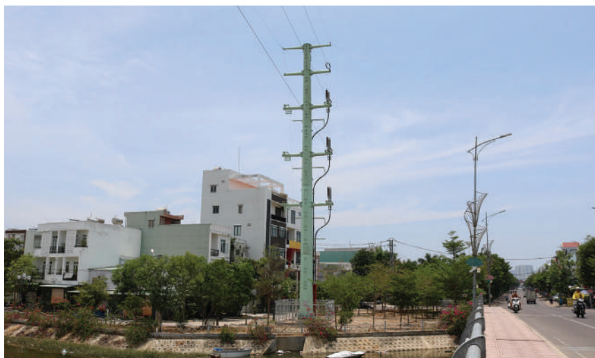
Tuyến đường dây 110kV phân đi nổi và tuyến cáp ngầm cũng được đóng điện đưa vào vận hành an toàn, tin cậy
