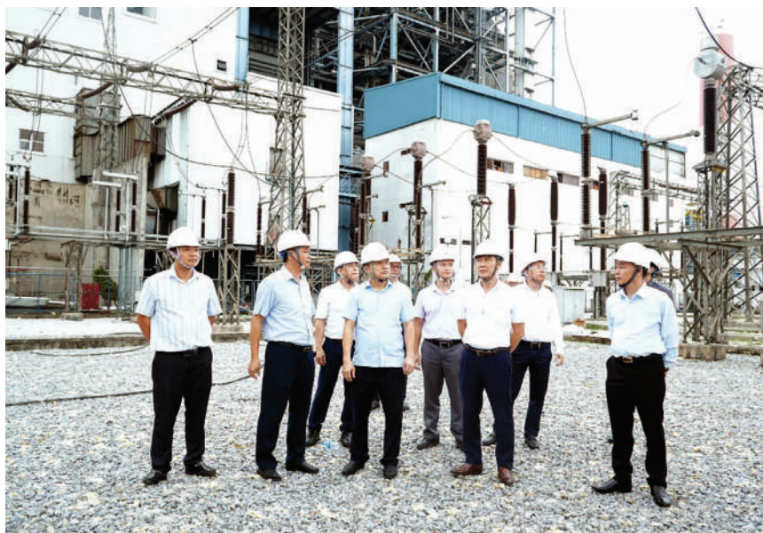
Lãnh đạo EVNGENCO1 kiểm tra, chỉ đạo công tác khắc phục hậu quả cơn bão số 3 tại Công ty Nhiệt điện Uông Bí
