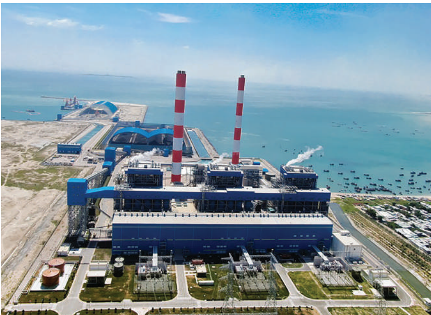
Nhà máy Nhiệt điện Vĩnh Tân 4 sử dụng công nghệ hiện đại, thân thiện với môi trường (Ảnh: PECC2)
