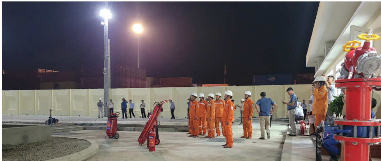
Lực lượng PCCC tại chỗ của PC Bình Định sẵn sàng trong thời điểm đóng điện MBA 63MVA
