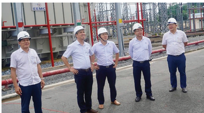
Phó TGD EVNNPT Bùi Văn Kiên kiểm tra Trạm biến áp 220kV Cần Thơ trước khi đóng điện Dự án
