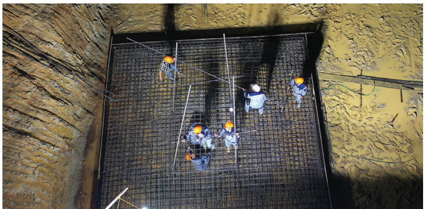
Thực hiện chỉ đạo của Thủ tướng Chính phủ, toàn công trường thi công với tinh thần “3 ca, 4 kíp”, xuyên lễ, xuyên Tết, xuyên ngày nghỉ
