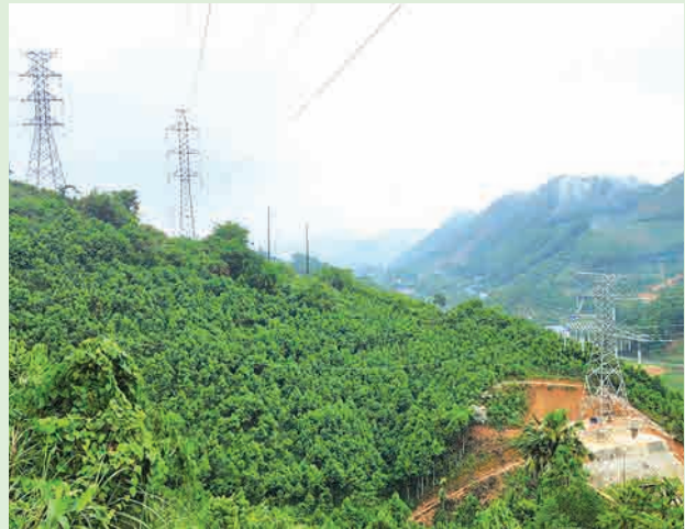
Dự án Đường dây 220kV mạch kép đầu nối TBA 220kV Bắc Quang đã được đóng điện thành công
