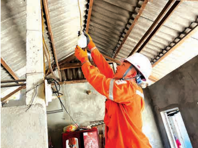
Đoàn thanh niên Điện lực Thạch Hà thực hiện chỉnh trang đường dây điện, lắp bóng đèn mới cho hộ gia đình chính sách, người có công với cách mạng.
