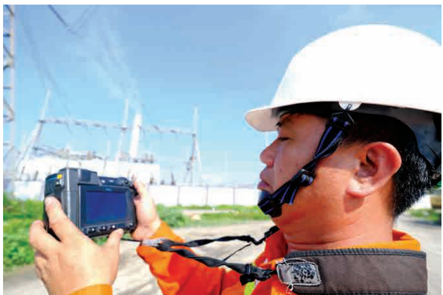
Công nhân TTD Đông Bắc 2 thực hiện kiểm tra nhiệt độ tại Trạm để đưa ra những giải pháp phù hợp trong những đợt nắng nóng cao điểm
