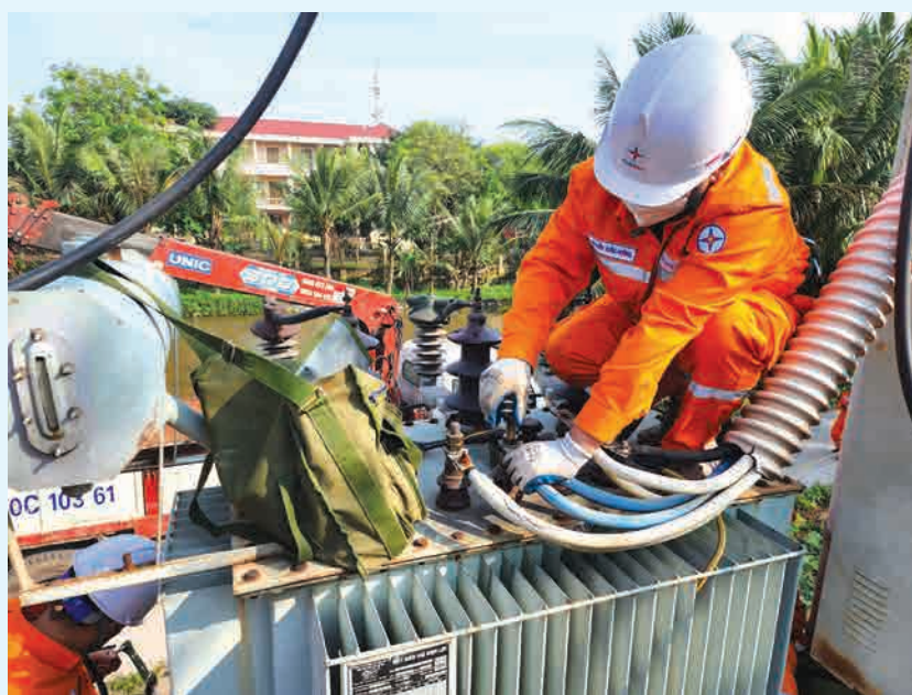
Sửa chữa bảo dưỡng máy biến áp
