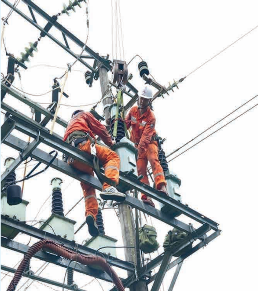
Điện lực Na Hang (PC Tuyên Quang) sửa chữa khiếm khuyết trên đường dây
