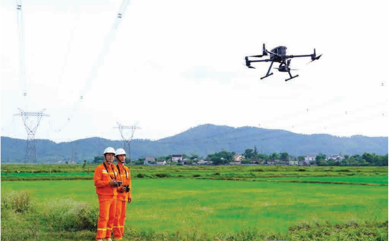
CBCNV PTC1 sử dụng Flycam bay kiểm tra sự cố trên đường dây
