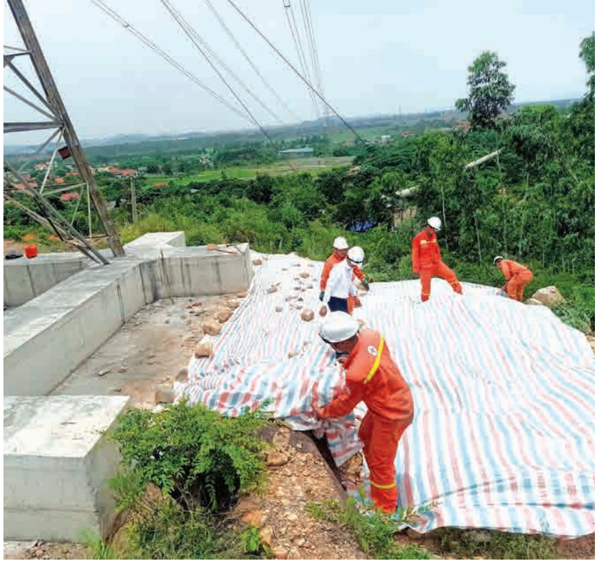
Các vị trí xung yếu đường dây 220kV Mạo Khê - Trảng Bách được gia cố chằng néo cẩn thận
