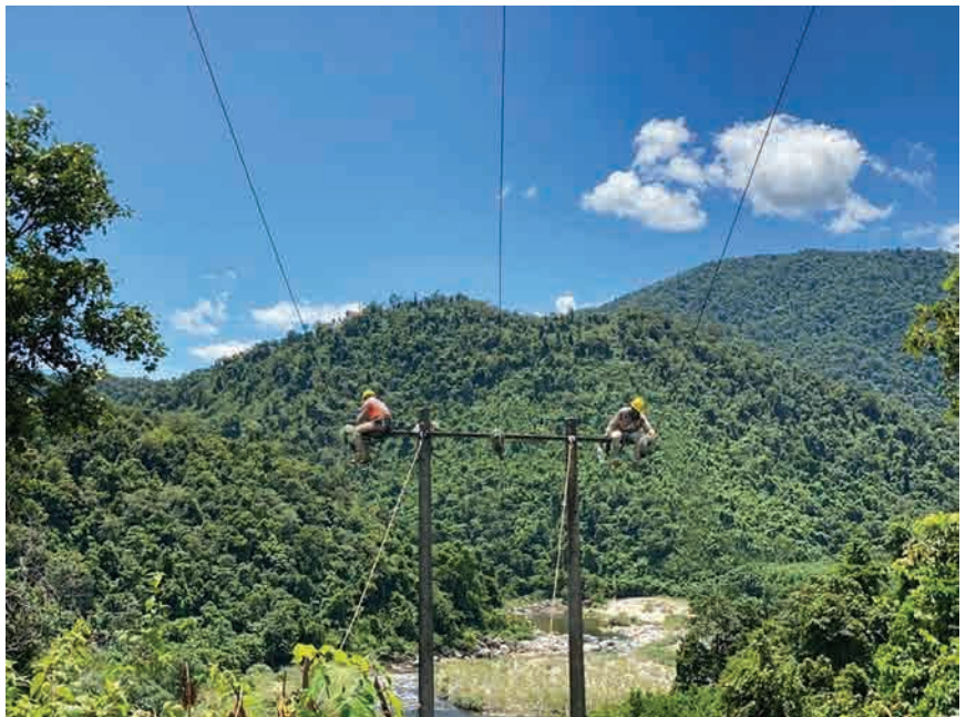
Công nhân Điện lực Hà Tĩnh miệt mài làm việc dưới cái nóng hơn 40 độ nhằm sửa chữa các khiếm khuyết để lưới điện vận hành an toàn, ổn định
