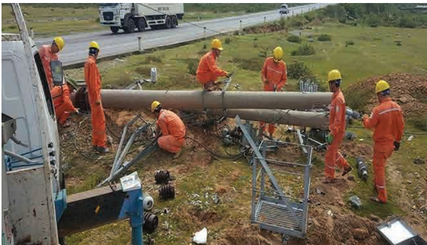
Bão tan cũng là lúc công việc của người thợ điện miền Trung nặng nề, vất vả hơn bao giờ hết
